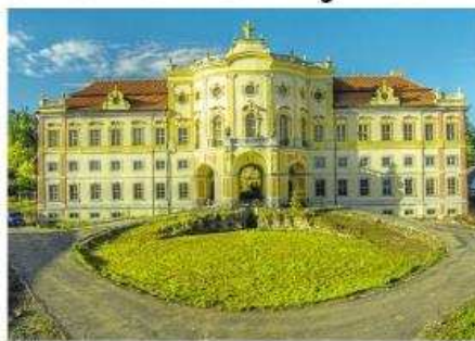
ZÁMEK TÝNEC na Klatovsku získal v soutěži Stavba roku Plzeňského kraje prestižní ocenění. Porota ocenila citlivou rekonstrukci objektu a také zapojení současného umění. Foto: Stavba Roku PK
