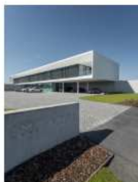
Administrativní budova Importo, Klatovy
