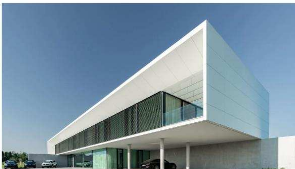
Administrativní budova Importo Klatovy.
